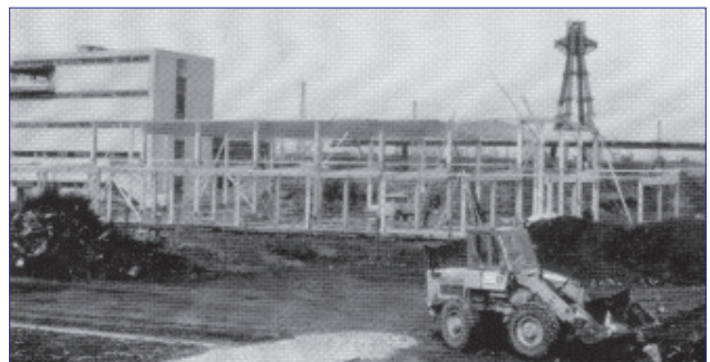
Das neue Sportzentrum an der Oskar-Vongerichten-Straße im Bau ...
