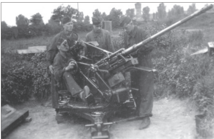
Flakstellung 1944 auf dem Sportgelände am Rangierbahnhof
