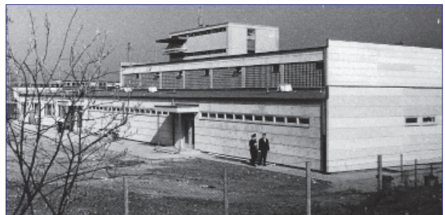
... und kurz vor der Fertigstellung
