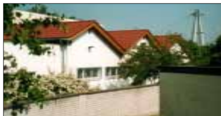
Der neue Sanitärtrakt mit Gymnastikraum von der Georg-Büchner-Straße aus ge-
