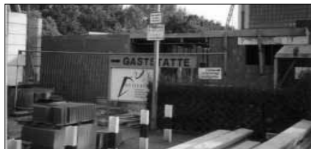
Der Anbau in der Rohbauphase 1998
